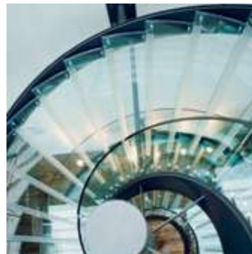
Linienförmige Lagerung einer begehbaren Verglasung
